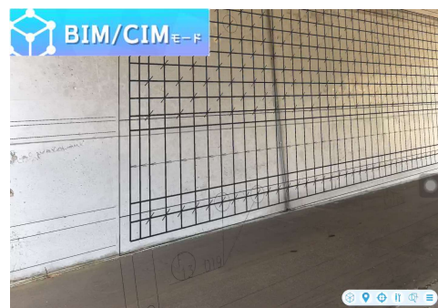
配筋図の確認
