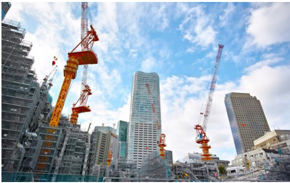
建設技術の継承
